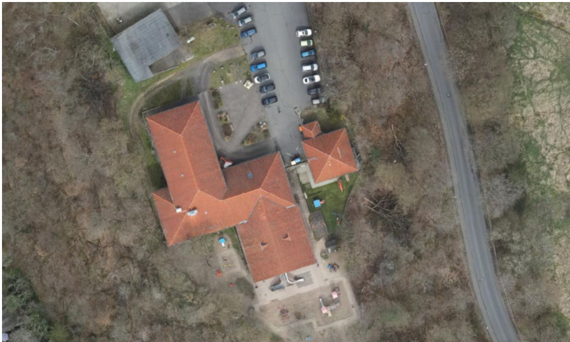
Abbildung 6: Detailliertes Drohnenluftbild von einem Teilbereich des Projektgebietes
